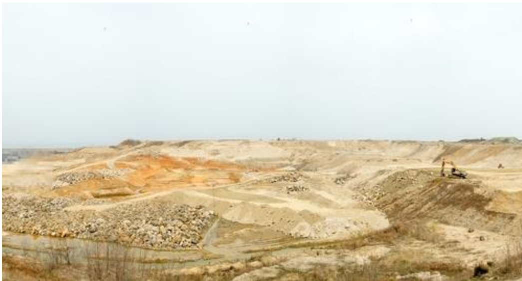
新韩蔚3号和4号机组建设现场
