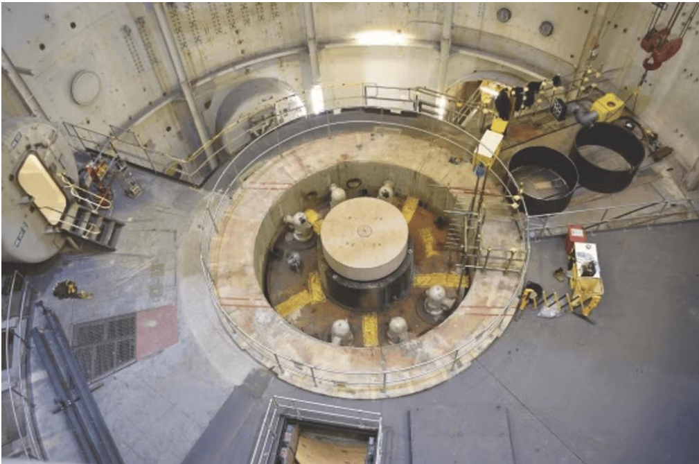
退役早期，移除主屏蔽塞，更换为预制混凝土临时屏蔽塞
