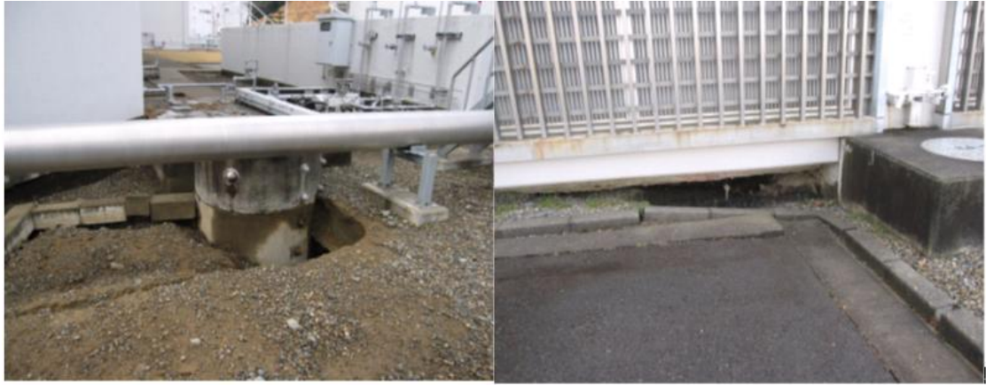
图 3-5 地震对福岛第二核电站产生的破坏
