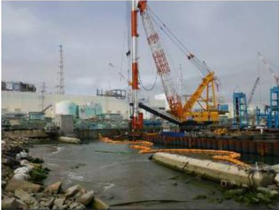
图 4-7 安装钢管板桩的情况
