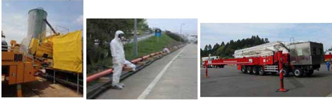
图 4-15 灌浆设施（从左到右依次为：制造、传送管、混凝土泵车）
