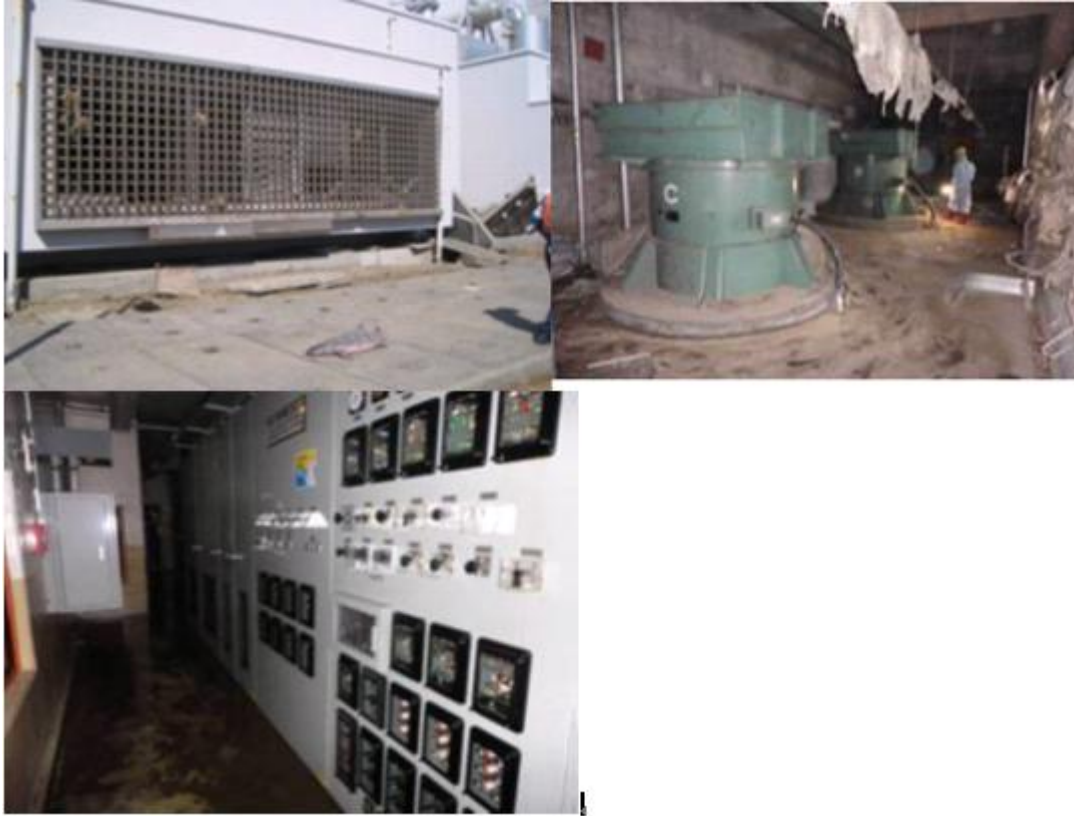
图 3-12 海啸对福岛第二核电站造成的破坏
