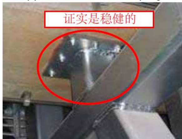
图 4-14 管道支撑结构
