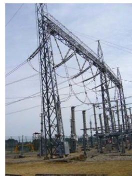
撮影：東京電力株式会社 H23.3.11
