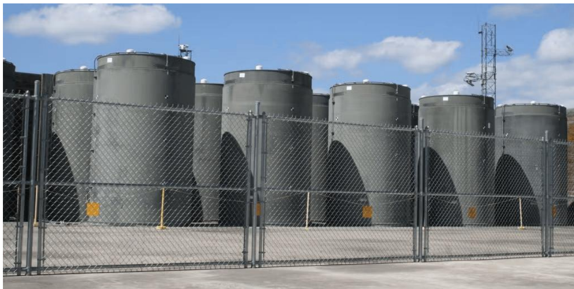
干式贮存 SSC 须确保临界安全、屏蔽、包容、热传导、结构完整性和可回取性
